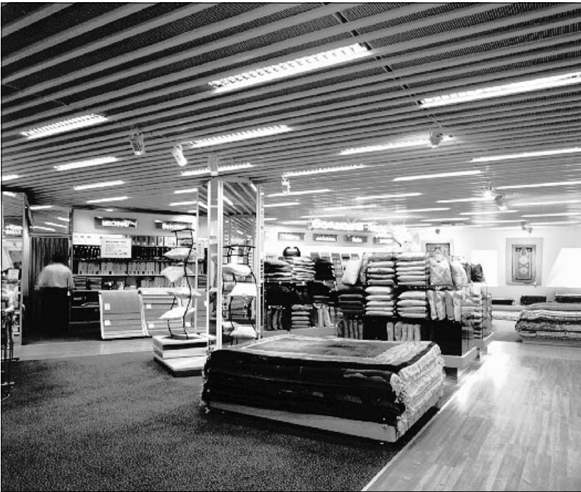
Figura 2.7: illuminazione generale con corpi illuminanti muniti di griglia (fonte: Regent)
